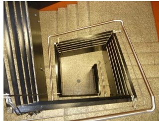
Treppe in der Kongresshalle vom Foyer zur Garderobe (UG.) und zum Foyer 1.OG/1.Rang
