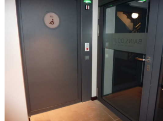
Tür zum barrierefreien WC Spa-Bereich
