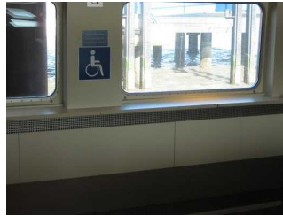
Vorgesehener Rollstuhlstellplatz auf dem Hauptdeck
