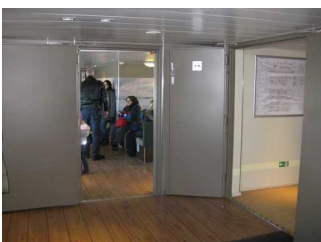
Durchgangstür auf dem Hauptdeck
