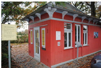
Bahnhofsgelände Eingang vom Parkplatz
