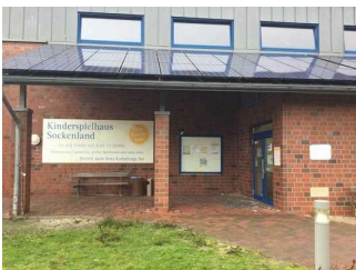
Eingangsbereich des Spielhauses Sockenland
