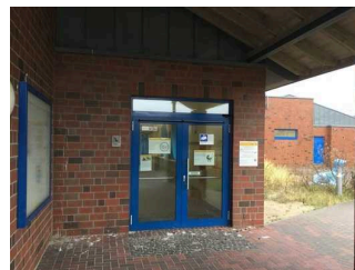
Eingangsbereich des Spielhauses Sockenland
