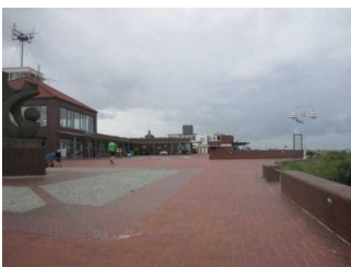
Weg vom Strandaufgang der oberen Strandpromenade zum öffentlichen WC
