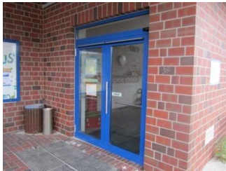
Eingangstür/ Außentür ins Sockenland
