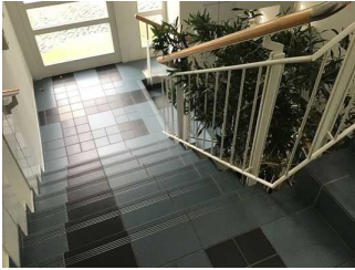
Treppe zum WC
