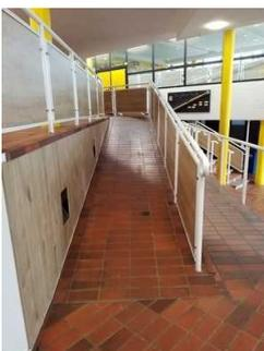
Maximale Längsneigung der Rampe: 20 %
