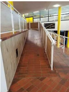
Maximale Längsneigung der Rampe: 20 %
