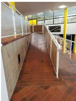
Maximale Längsneigung der Rampe: 20 %
