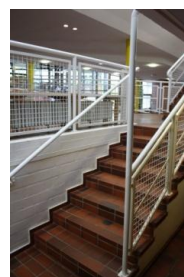
Treppe auf dem Weg zu Zimmer 8
