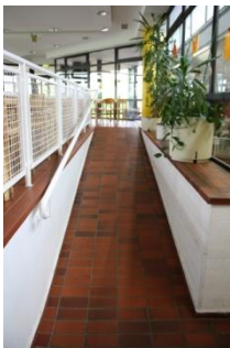
Rampe zum Speiseraum
