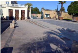
Rampe/Stufen vor dem Eingang
