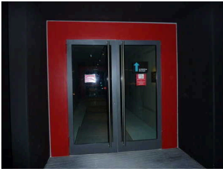
Tür 1 zum unter-Tage-Bereich
