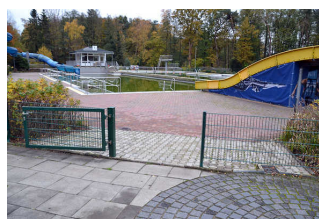
Weg außen zum Schwimmbecken
