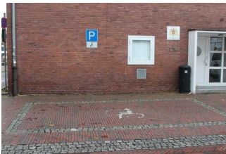
Parkplatz für Menschen mit Behinderungen am Neuen Rathaus-Frontal
