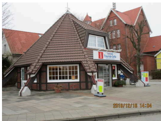
TI-Döse Außenansicht: weiße Tür links = öffentliches WC; rechts Haupteingang
