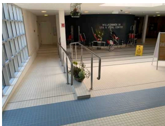
Weg innen zur Umkleide, WC und Spa & Vital Center
