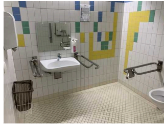
WC Dusche im Umkleidebereich
