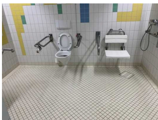
WC Dusche im Umkleidebereich
