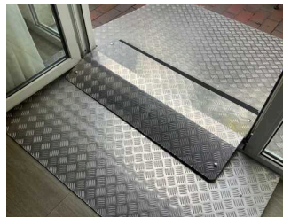
Rampe über die Türschwelle
