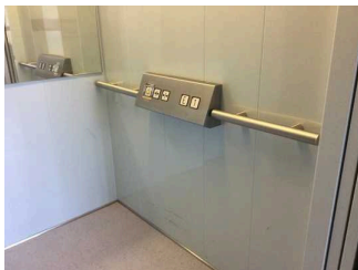
Aufzug zwischen Eingang und Ferienwohnung im Obergeschoss
