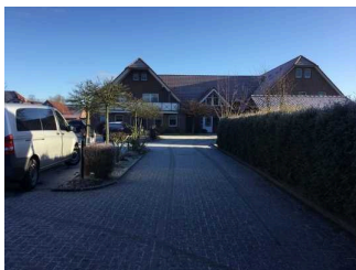
Weg vom Parkplatz zum Eingang
