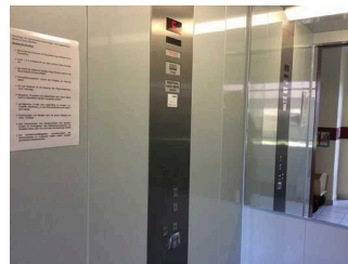
Aufzug zwischen Eingang und Ferienwohnung im Obergeschoss
