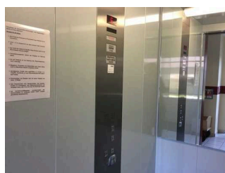
Aufzug zwischen Eingang und Ferienwohnung im Obergeschoss
