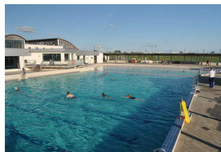
Weg außen rund um das Schwimmbecken
