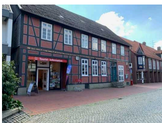
Weg außen vor der TI
