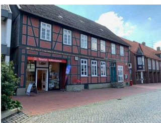
Weg außen vor der TI
